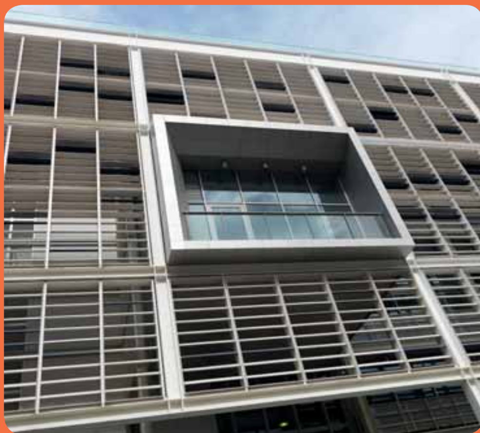
Использование керамики позволяет совместить в одном здании вентилируемый фасад и жалюзи.
