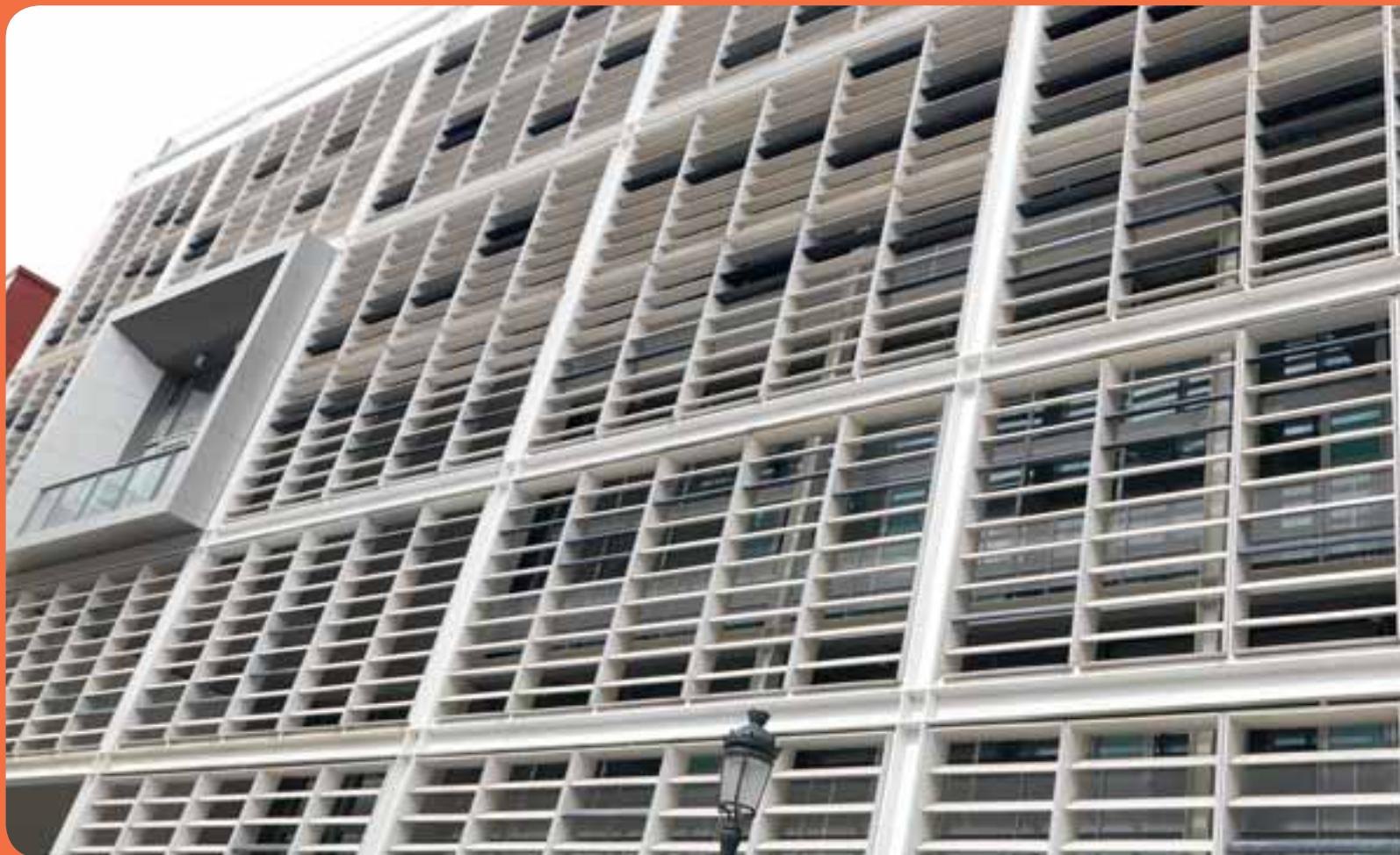
Экструдированные керамические изделия имеют специальный дизайн, позволяющий избежать налипания загрязнений.
